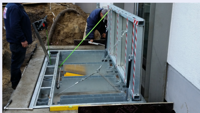
Einbau eines Klappschotts
