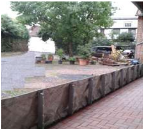
Hochwassereinsatz mobiler Hochwasserschutz an der Küste
