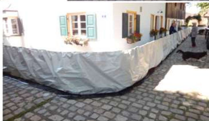
Hochwasserschutz mobiler Hochwasserschutz um ein Haus herum
