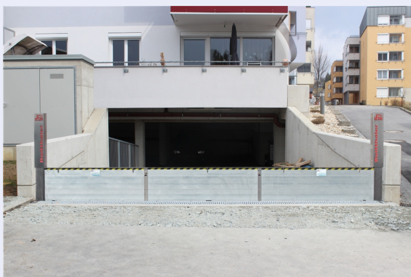
CHT-Vertikalschott in Hochwasserschutzposition
